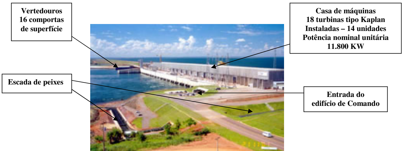
Usina Hidrelétrica de Porto Primavera – (em primeiro plano, vista da escada de peixes).
